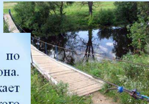
Навесной мост в районе Грязиловки
