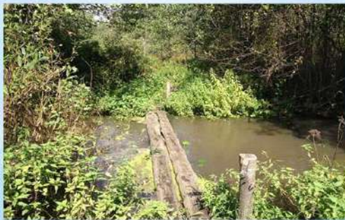
Мост через реку Дерновку
